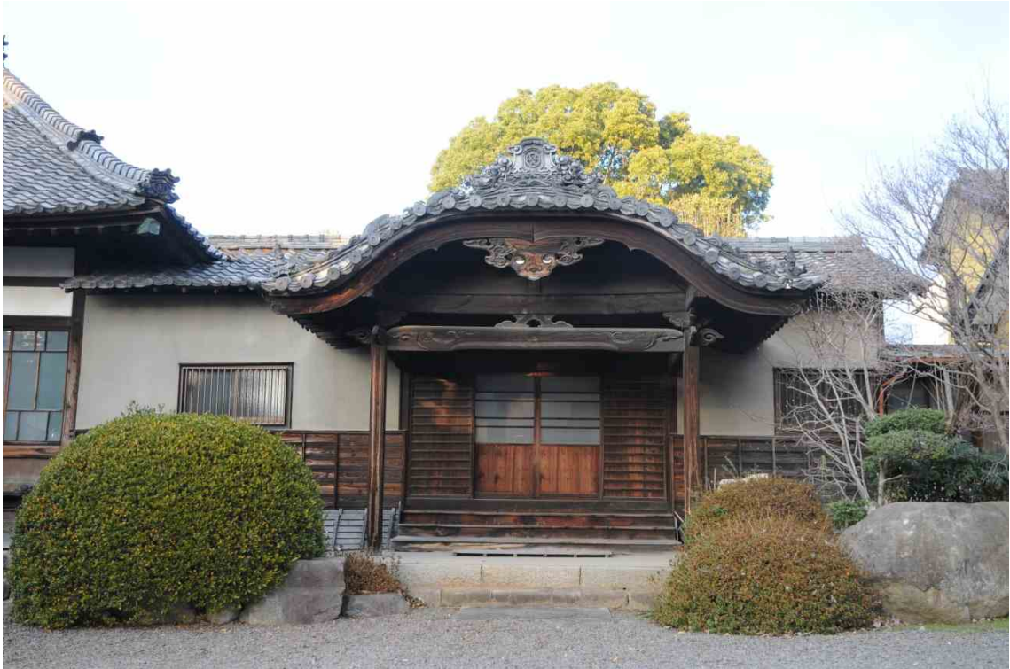
玄関 外観 南より (岡崎市教委提供)
